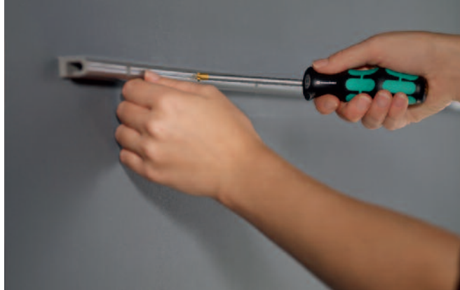
Na stěnu připevníme plastovou kolejnici ...
